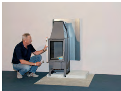
3. Ustawić i wypoziomować wkład kominkowy
