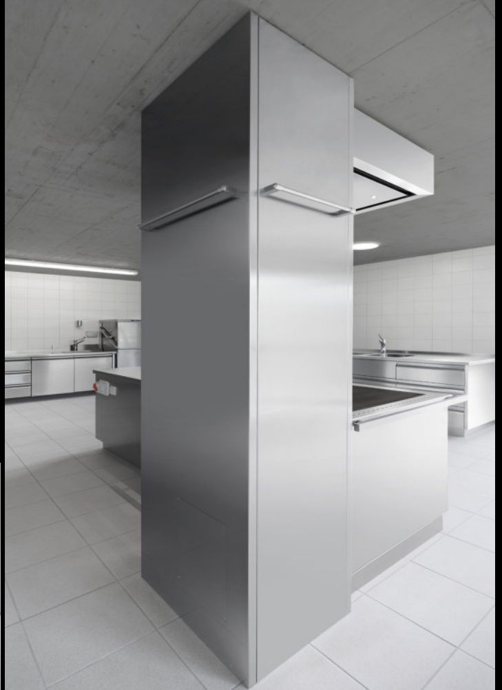
Säule komplett in Edelstahl verkleidet
